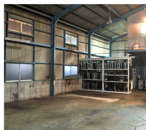
使っていない工場や倉庫
