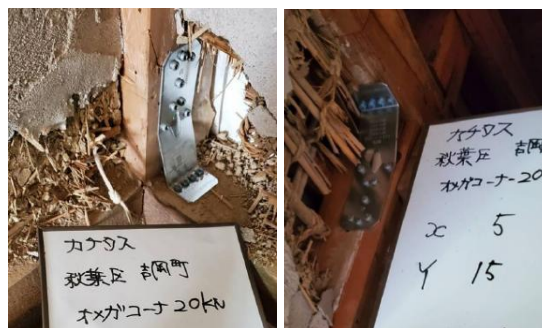
補強金物の設置例
