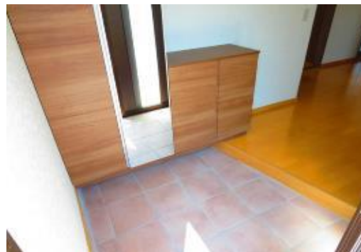
カーペット敷きの床をフローリングに換え、玄関ポーチのタイルはテラコッタ調とし、新品のシューズボックスを設置して生まれ変わった玄関(高知県)
