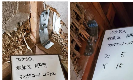
補強金物の設置例
