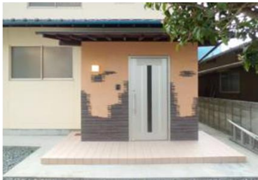
ポーチのタイルを貼りかえ、玄関ドアも新品に交換し、外壁にアクセントタイルを貼付(高知県)
