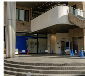
ビル入口の 空きスペース
